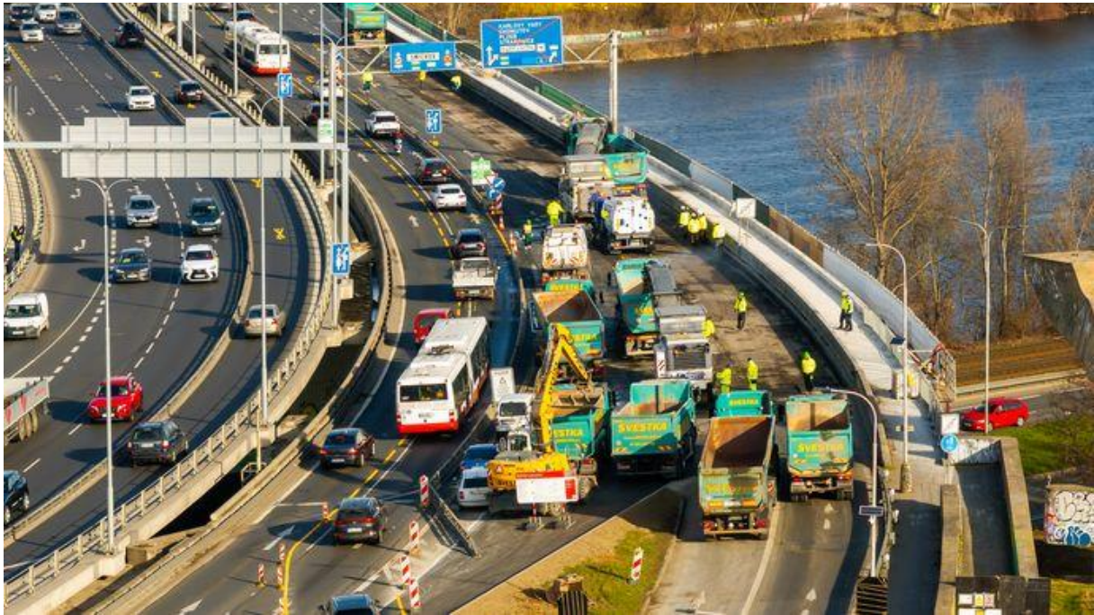
Momentka z probíhajících oprav Barrandovského mostu
