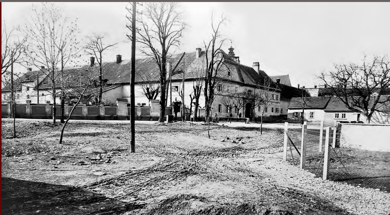
Někdejší sídlo schwarzenberské správy s panským dvorem v Jinonicích
