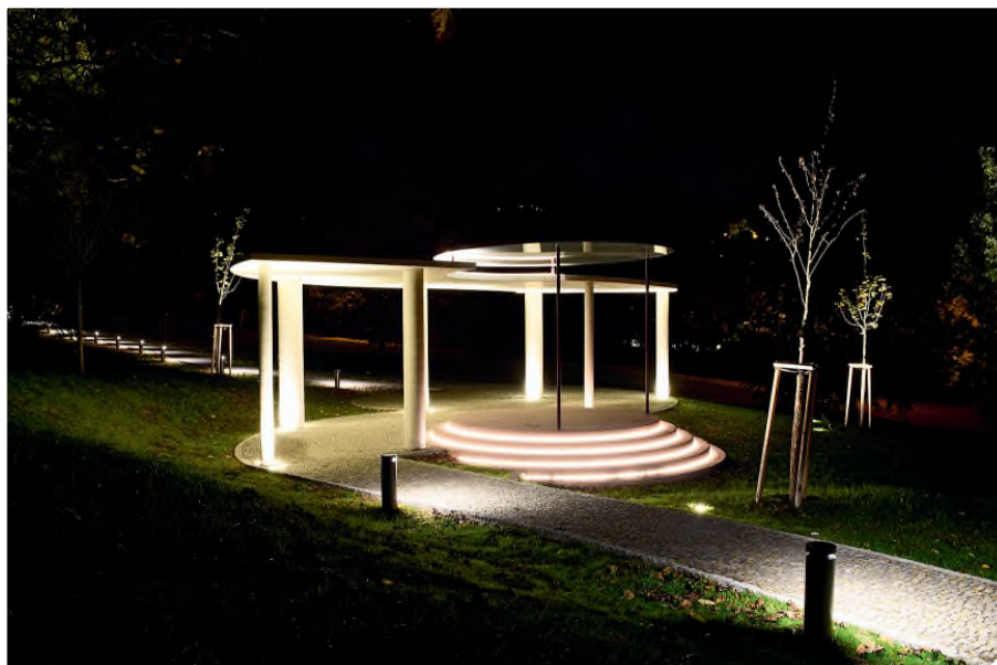
Pavilon je zhotoven z pohledového betonu světlého přírodního odstínu s piedestalem, který dotváří skleněná designová střecha
