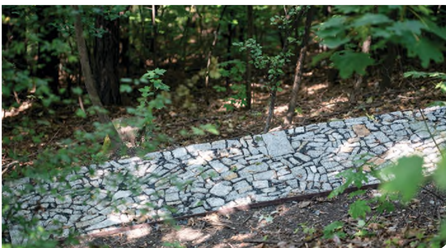
Nového kabátu či opravy se dočkaly poškozené cesty, schodiště, zábradlí a zídky
