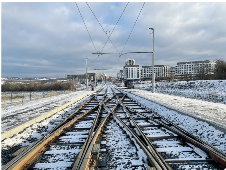
Výstavba nového úseku trati byla zahájena letos 2. února
