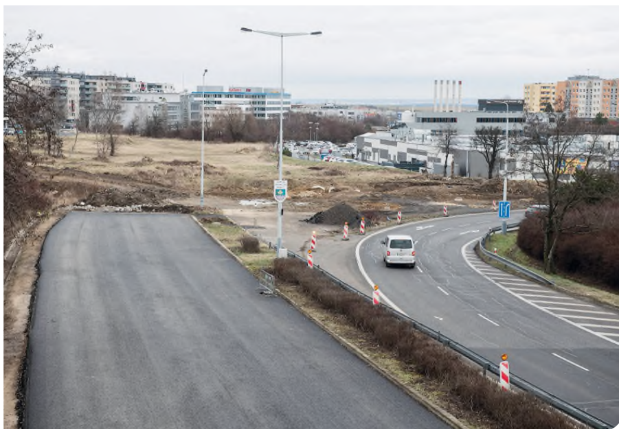
Nad dokončením stále visí otazníky
