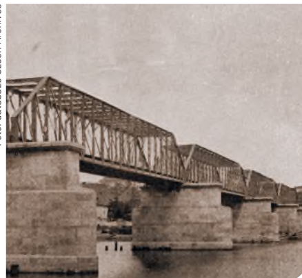
ROK 1875. Železnou konstrukci zhotovila firma založená Johannem C. Harkortem nedaleko Duisburgu v Porýní.
