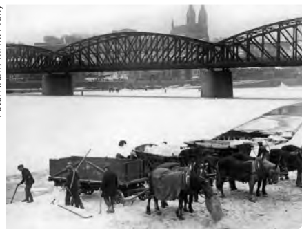
ROK 1929. Na Smíchově patřilo sekání ledu pro domácí chladírny ke každoročním rutinám.
