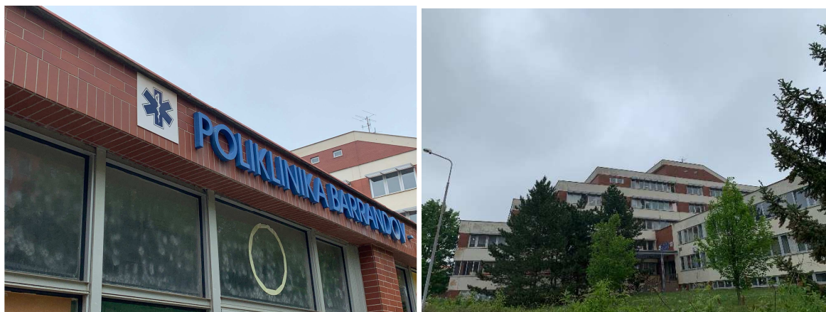
Stav před zahájením projektu
