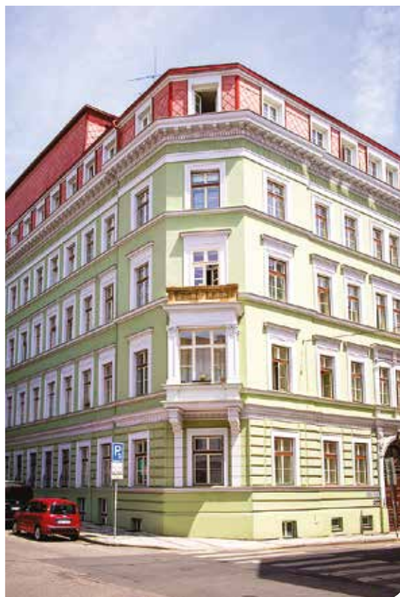
Dům s pečovatelskou službou v Zubatého ulici prošel nedávno rozsáhlou rekonstrukcí
