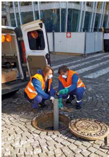
Hubicí návnady se vkládají přímo do kanalizační stoky
