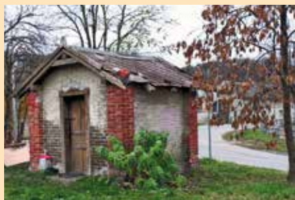
Domek například získal nový krov včetně střešní krytiny
