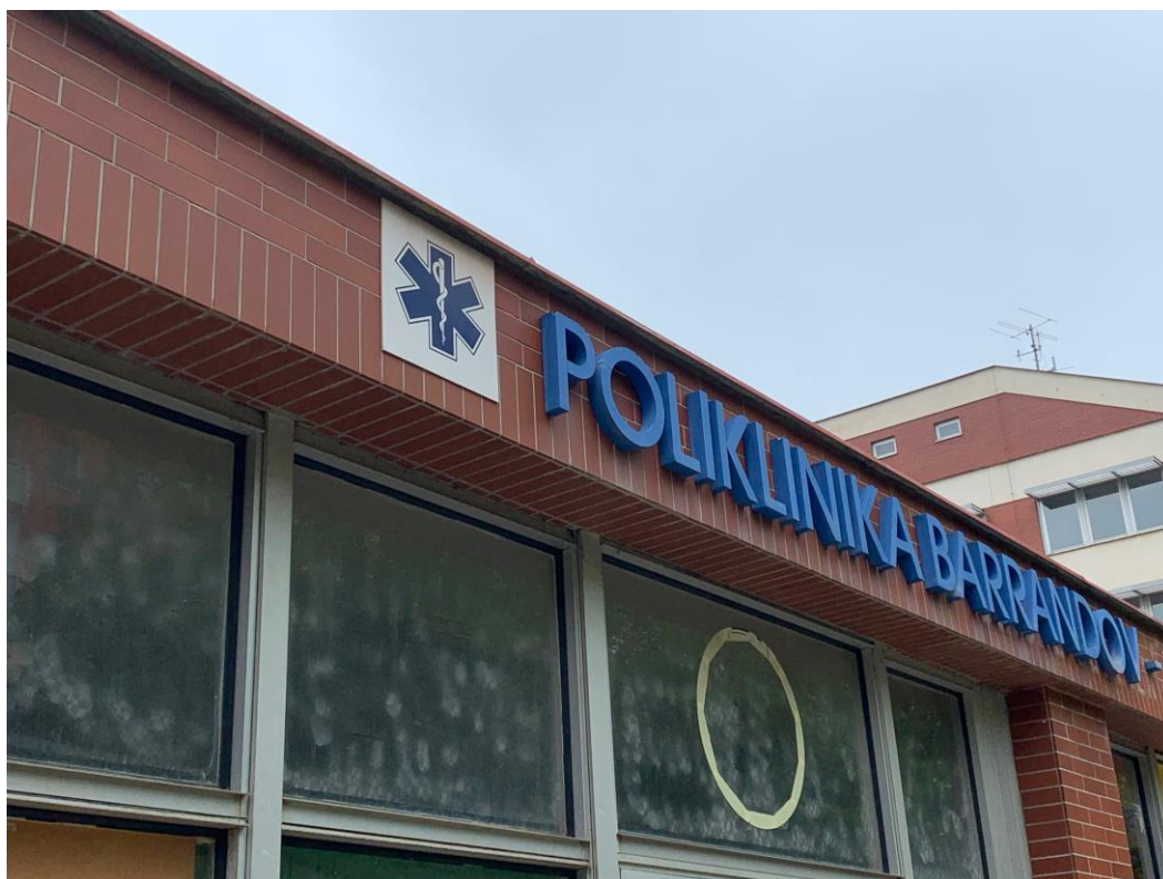
Stav před zahájením projektu
