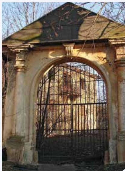
Současná podoba hlavního vchodu usedlosti
