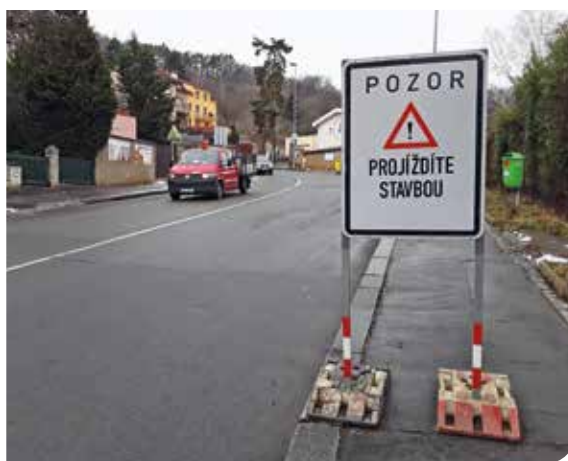
Klikatá ulice v Jinonicích je stále v neutěšeném stavu. Správce komunikací slibuje, že k nápravě by mohlo dojít do léta.
