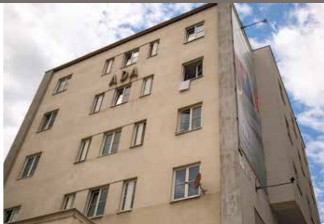
Stav vily Áda před rekonstrukcí v polovině letošního roku a nyní
