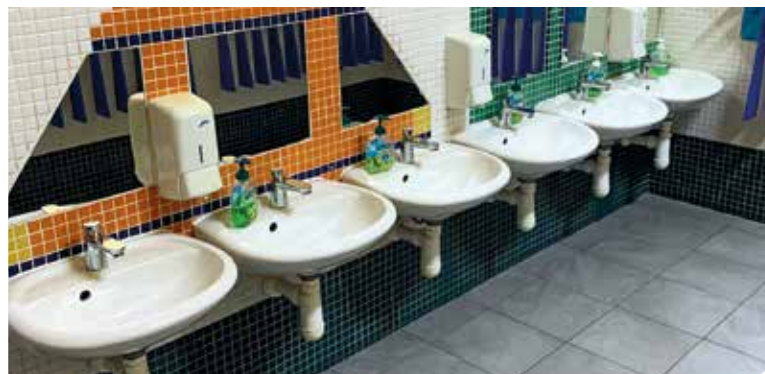
Škola vyměnila vybavení sociálních zařízení
