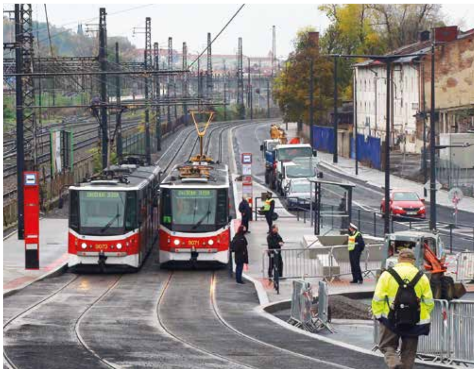
Oprava Nádražní ulice trvala přes sedm měsíců
