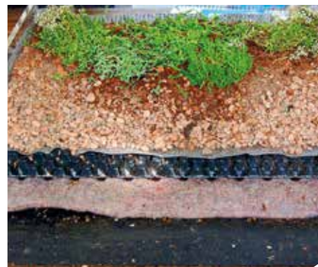
Řez konstrukční skladbou zelené střechy
