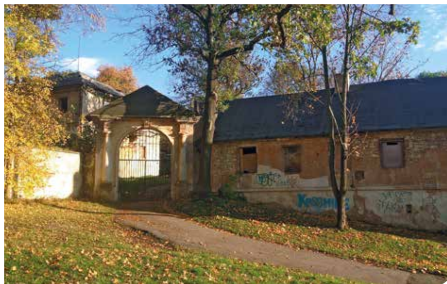
Usedlost Cibulka je ve špatném technickém stavu.
