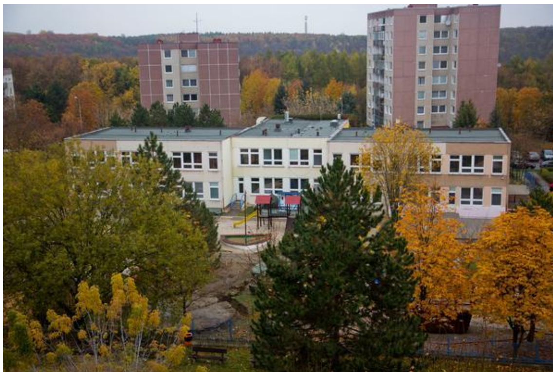
Stav MŠ Lohniského č.p. 830 před realizací projektu.
