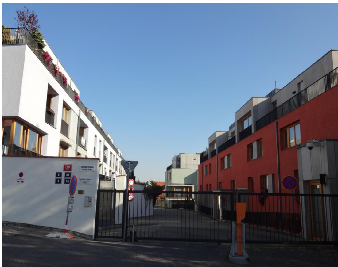
Obrázek 4.10: Uzavřený rezidenční komplex Vila Park Jinonice
