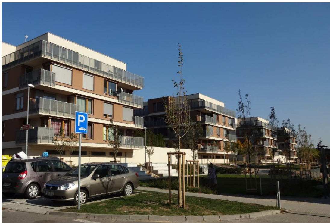
Obrázek 4.9: Rezidenční čtvrť Botanika – bytové domy
