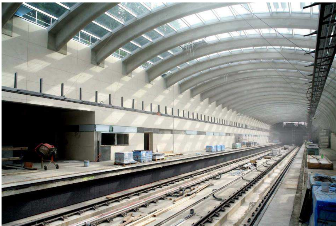
Obr. 15. Výstavba prodloužení trasy A
