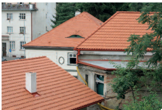
↓ BUĎÁNKÁ DOSTALA NOVOU STŘECHU Stavební práce na Budánkách úspěšně pokračují a budovy už mají krásné nové střechy.
