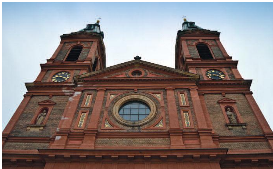
Kostel byl postaven v novorenesančním stylu
