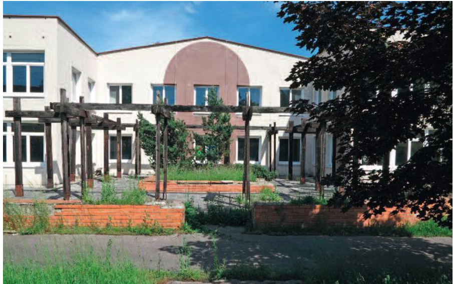
Rekonstrukce objektu začne v příštím roce
