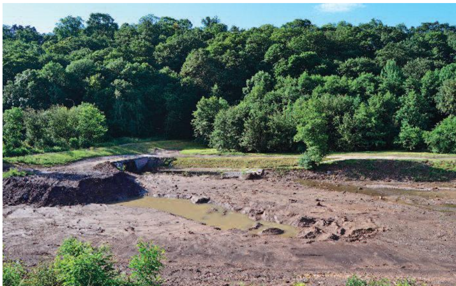
Stavební práce by měly skončit ještě letos
